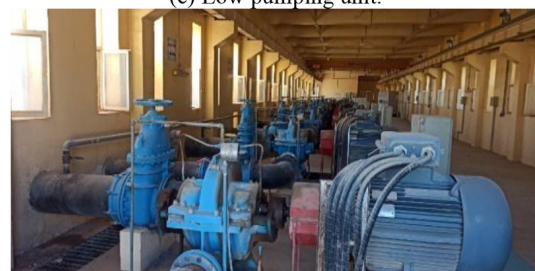
(d) High pumping unit.
